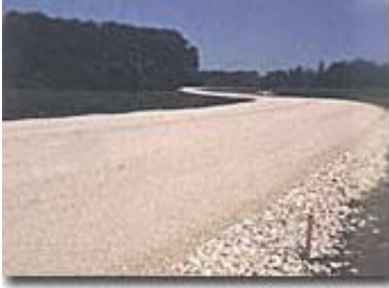
الشكل (2-32): اعادة استخدام البيتون المدور في انشاء الطرق بكندا .
