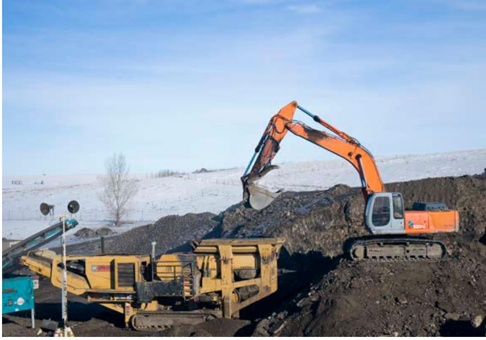
الشكل ( 2-16 ) محطة تدوير متكاملة ثابتة.
