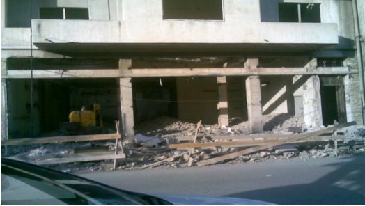
شكل رقم 2-2 يبين أعمال هدم وعزل عناصر الهدم لبناء منعزل يدوياً
