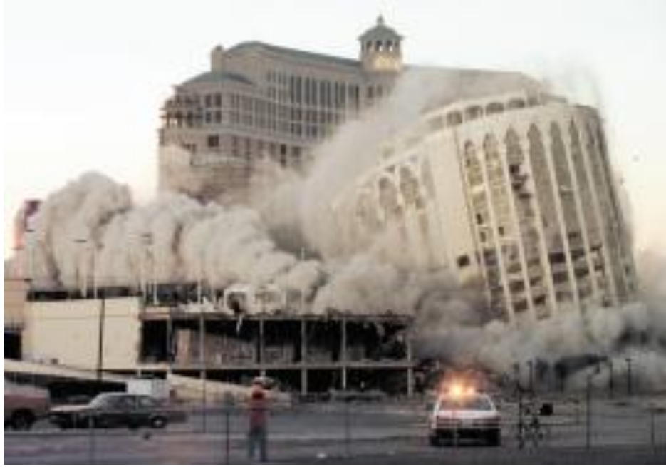
شكل رقم 2-6 الهدم بالتفجير لأحد الفنادق في لاس فيجاس الولايات المتحدة الأمريكية .
