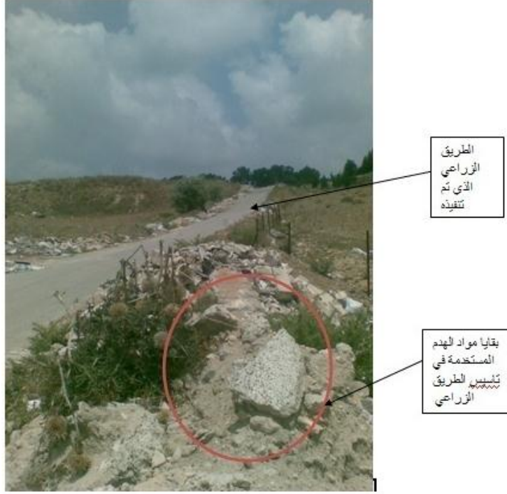
شكل رقم 4- 24: صورة توضح الطريق الزراعي الذي تم تنفيذه في (مقبرة بسنادا) باستخدام بقايا مواد هدم أبنية بيتونية المنشأ .
